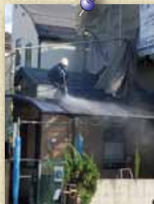
水洗・下地補修
